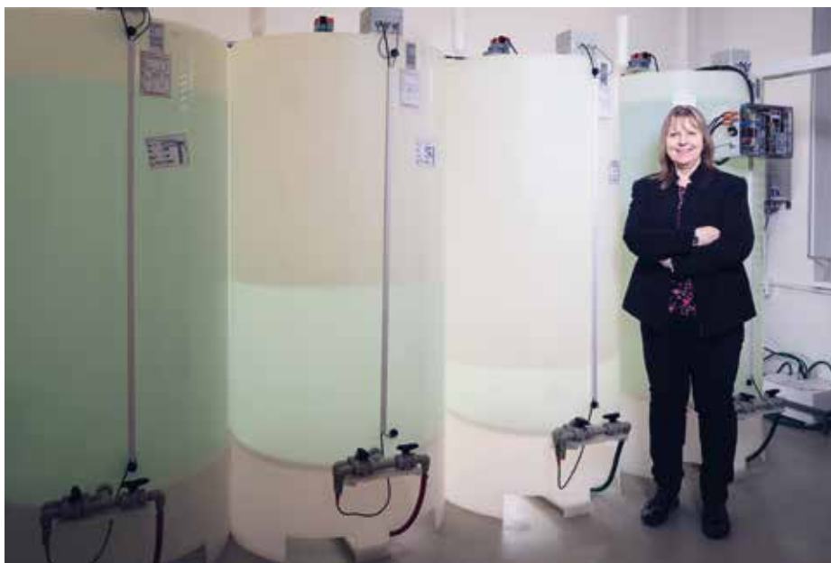
Jitka Pancířová, globální manažerka kvality pro dialyzační střediska ve společnosti B. Braun Avitum, stojící před nádržemi přístroje pro přípravu A-konzentrátu a jeho distribuci přímo k dialyzačním přístrojům na dialyzačním středisku v Tepličích
