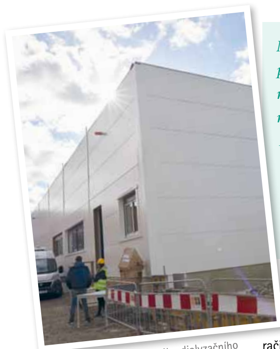
Budova nově připravovaného dialyzačního střediska v Teplicích
